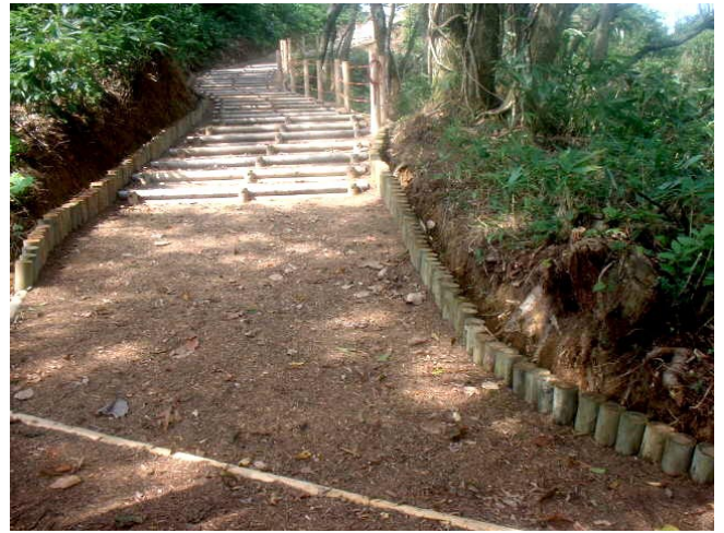
修景連杭施工例
