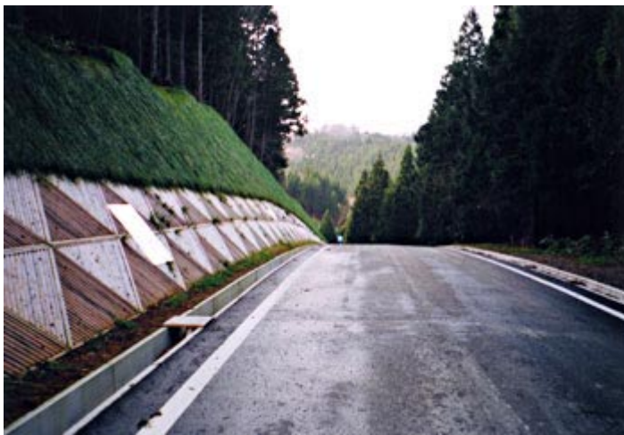
法面保護工（防草パネル）施工例
