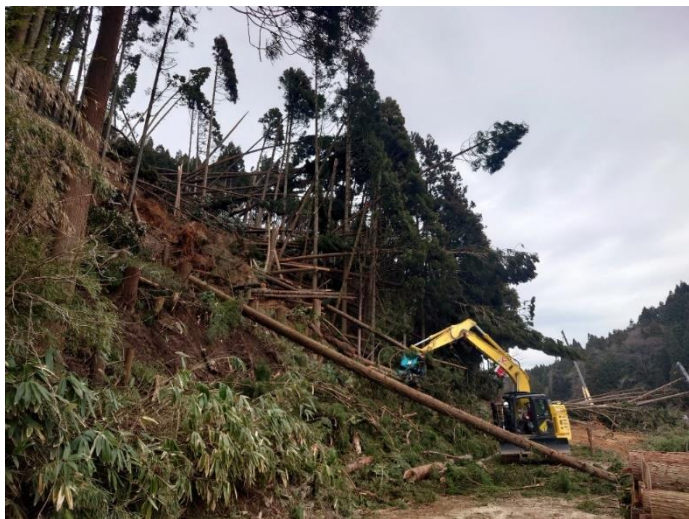
倒木処理作業の様子（県道 輪島富来線）
