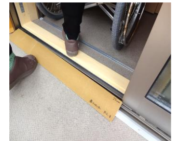
段差解消(くさび設置)
