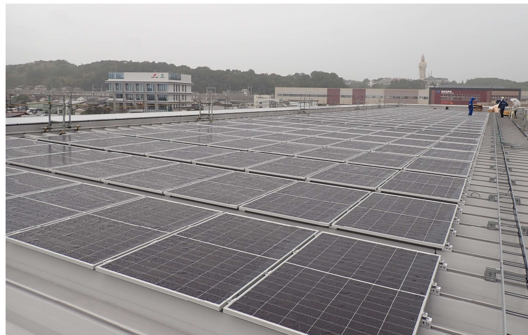
加賀市医療センター ※施工中
