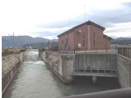
写真1 七ヶ用水発電所
