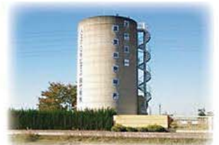
宮竹用水第一発電所(能美市) 管理者：手取川宮竹用水土地改良区
