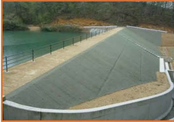
事業により改修されたため池
