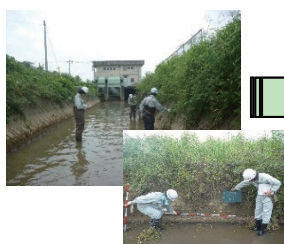
農業用水路の点検・診断状況
