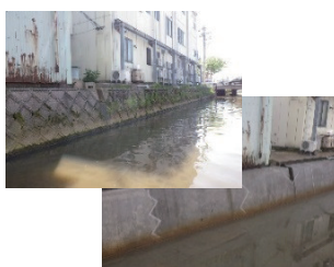
既存農業用水路の補修状況 (コンクリート表面被覆)
