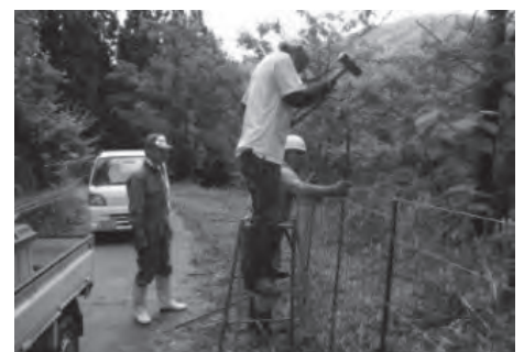
【獣害防止柵設置の様子】
