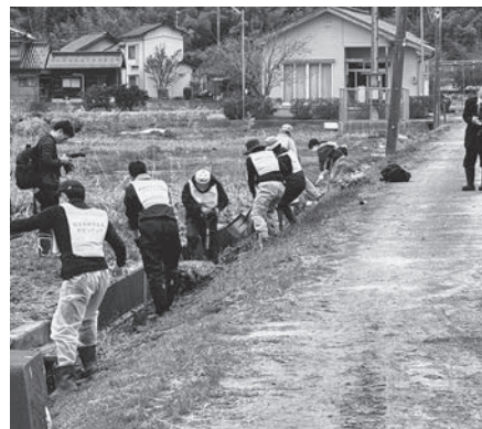
能登農林水産業ボランティアによる水路の泥上げ（能登町）
