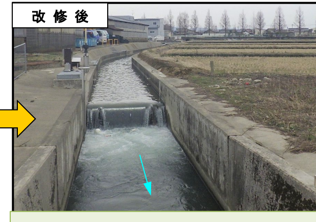
水路断面を大きくし、流下能力が向上
