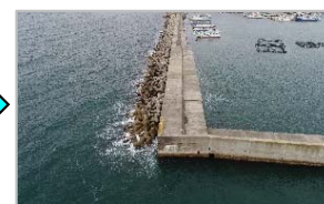
防波堤の整備により、港内の静穏度を確保し、畜養・養殖を実施
