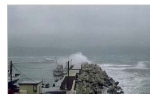
波浪による港内への越波状況
