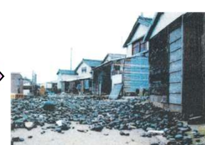
漁港のみならず、背後の一般家屋への被害が発生
