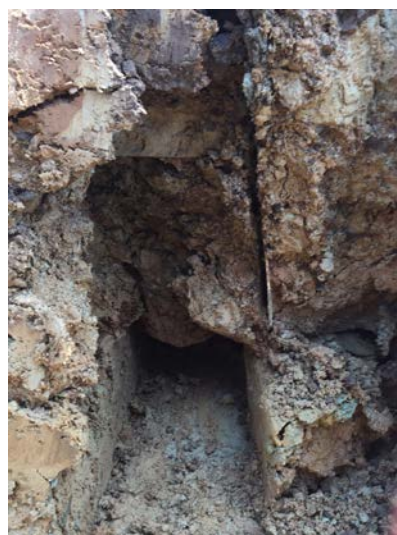
図2 カットドレーンによる造成暗渠
