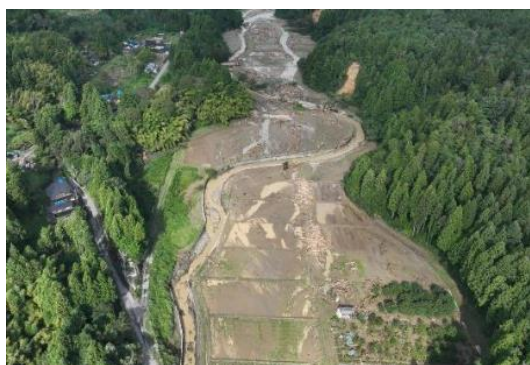
農地への土砂流入(珠州市)
