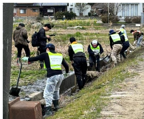
ボランティアによる水路の泥上げ
