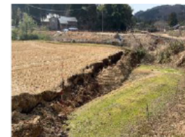
農地の地割れ (珠洲市)
