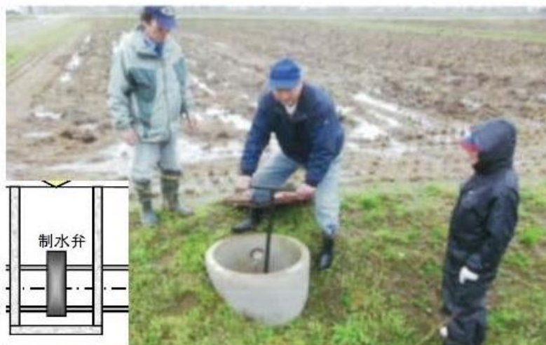
弁の動作確認状況
