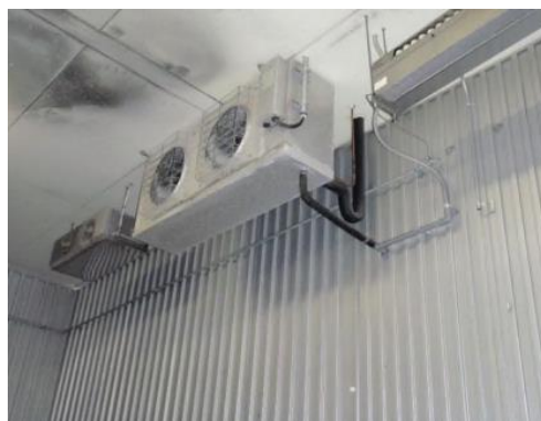
図2. 空調設備の清掃・メンテナンス
