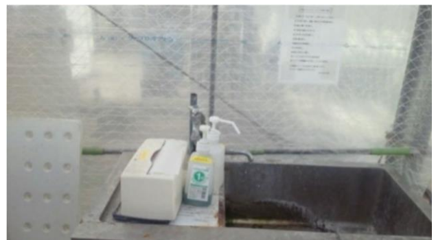
図2. 手洗い設備の管理
