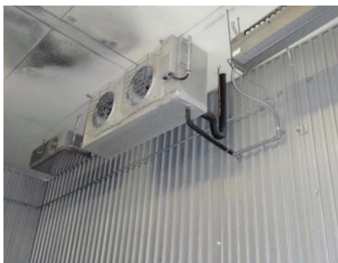
図2. 空調設備の清掃・メンテナンス
