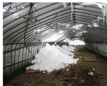
ハウスビニール切断
