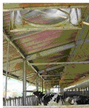
【送風ファンに細霧装置を設置】
