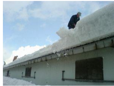
【人力による畜舎屋根の除雪】
