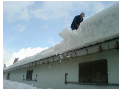
【人力による畜舎屋根の除雪】
