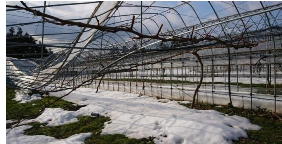
天パイプ部分に巻き上げ収納したビニールが緩み、雪が積もって倒壊した事例
