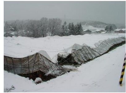
連棟ハウスは特に雪に弱い
