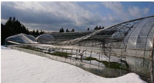
天パイプ部分に巻き上げ収納したビニールが緩み、雪が積もって倒壊した事例
