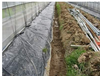
ハウス周辺の排水溝
