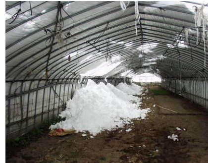
ハウスビニール切断
