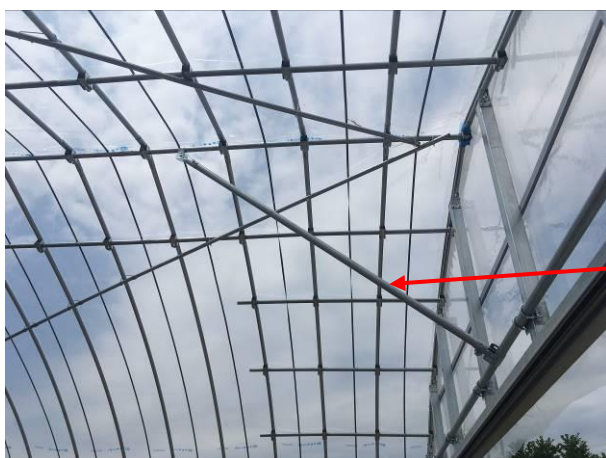
写真1 妻面の補強
