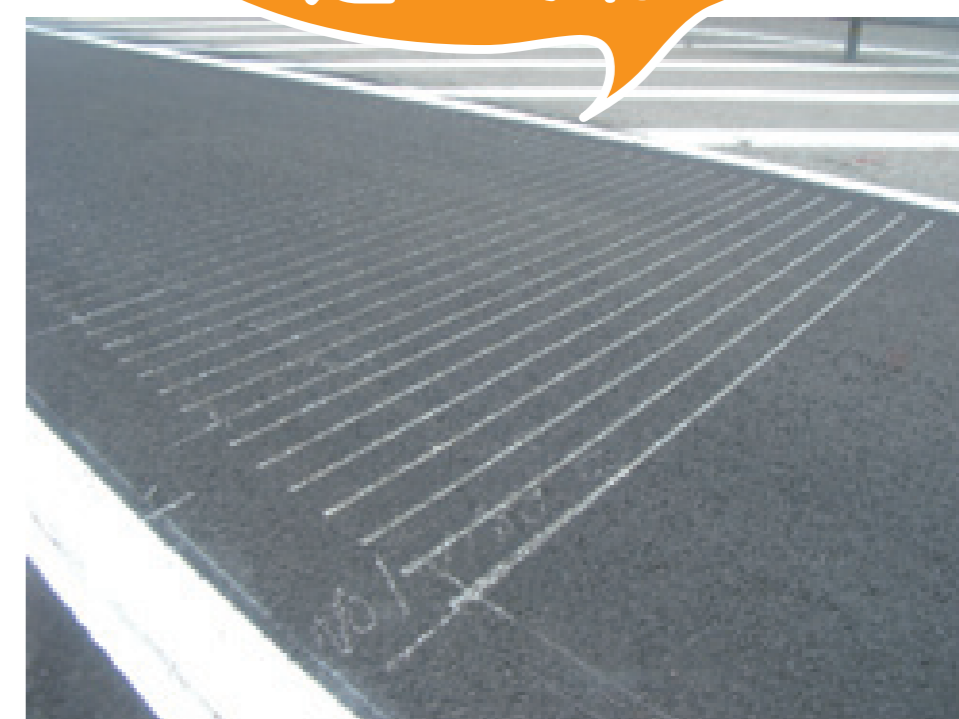
道路面に刻まれた溝
