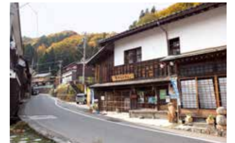
重要伝統的建造物群保存地区(白山市白峰)
