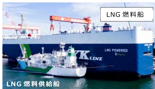
LNG バンカリング船の基地
