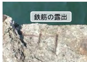
図 4-27 港湾施設の老朽化状況
