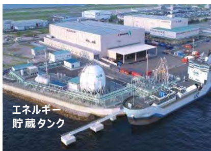
新エネルギーの受入・供給基地
