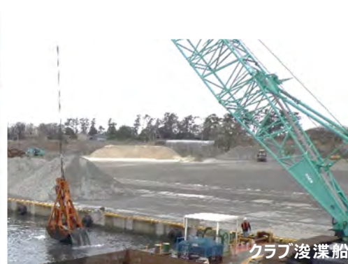
図 5-42 泊地浚渫状況
