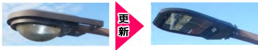
図 5-35 照明灯のLED化
