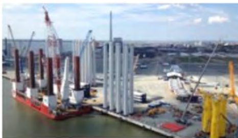
洋上風力発電の組立基地
