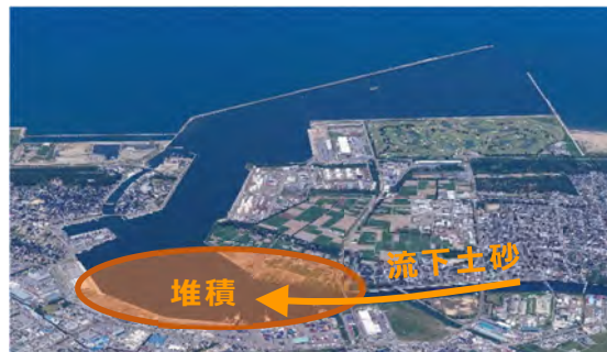
図 4-28 海・川から港内への土砂流入
