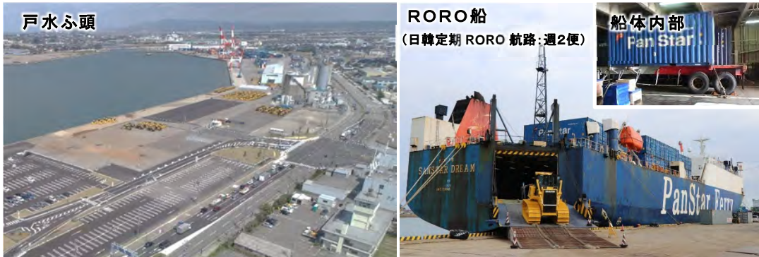
図 1-11 南地区（戸水ふ頭）の現状
