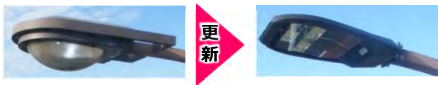
図 5-35 照明灯のLED化
