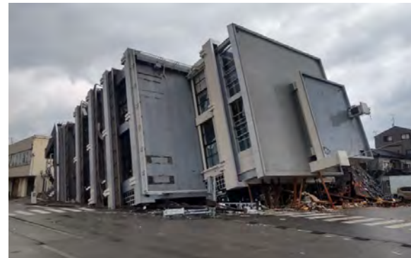
建物倒壊 (輪島市河井町地内)
