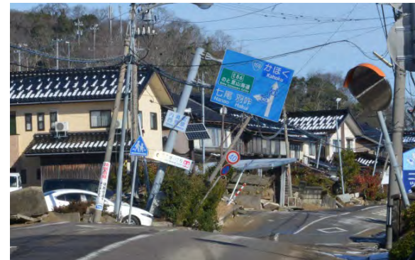
液状化 (内灘町西荒屋地内)
