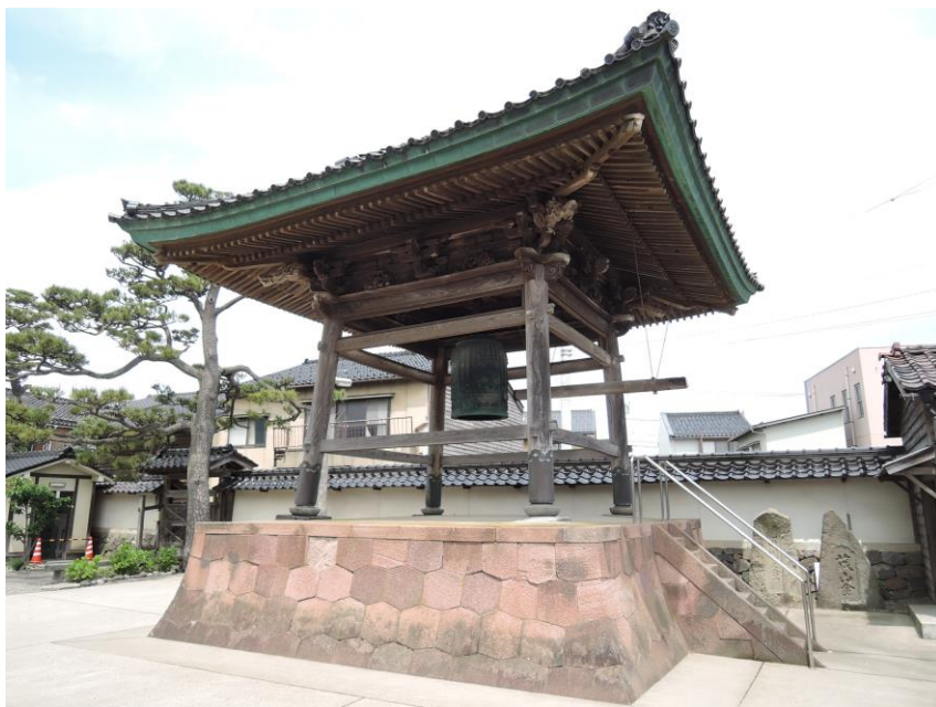
本龍寺 鐘楼（金沢市指定有形文化財建造物）
