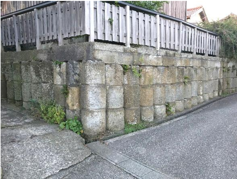
安宅愍念寺のたんころ石の擁壁
