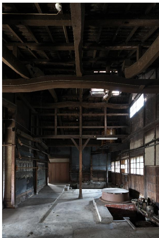
作業場内部（北から）
