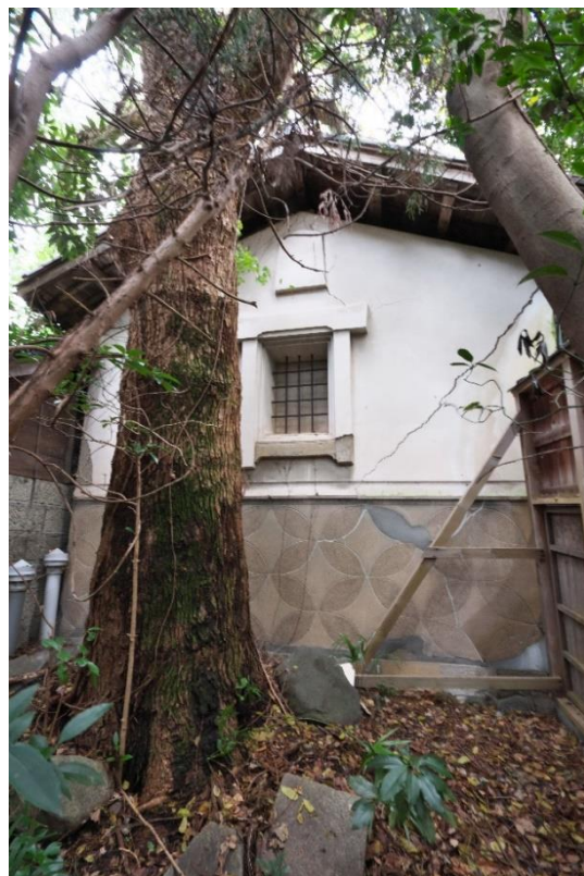
貯蔵庫外観（西から）
