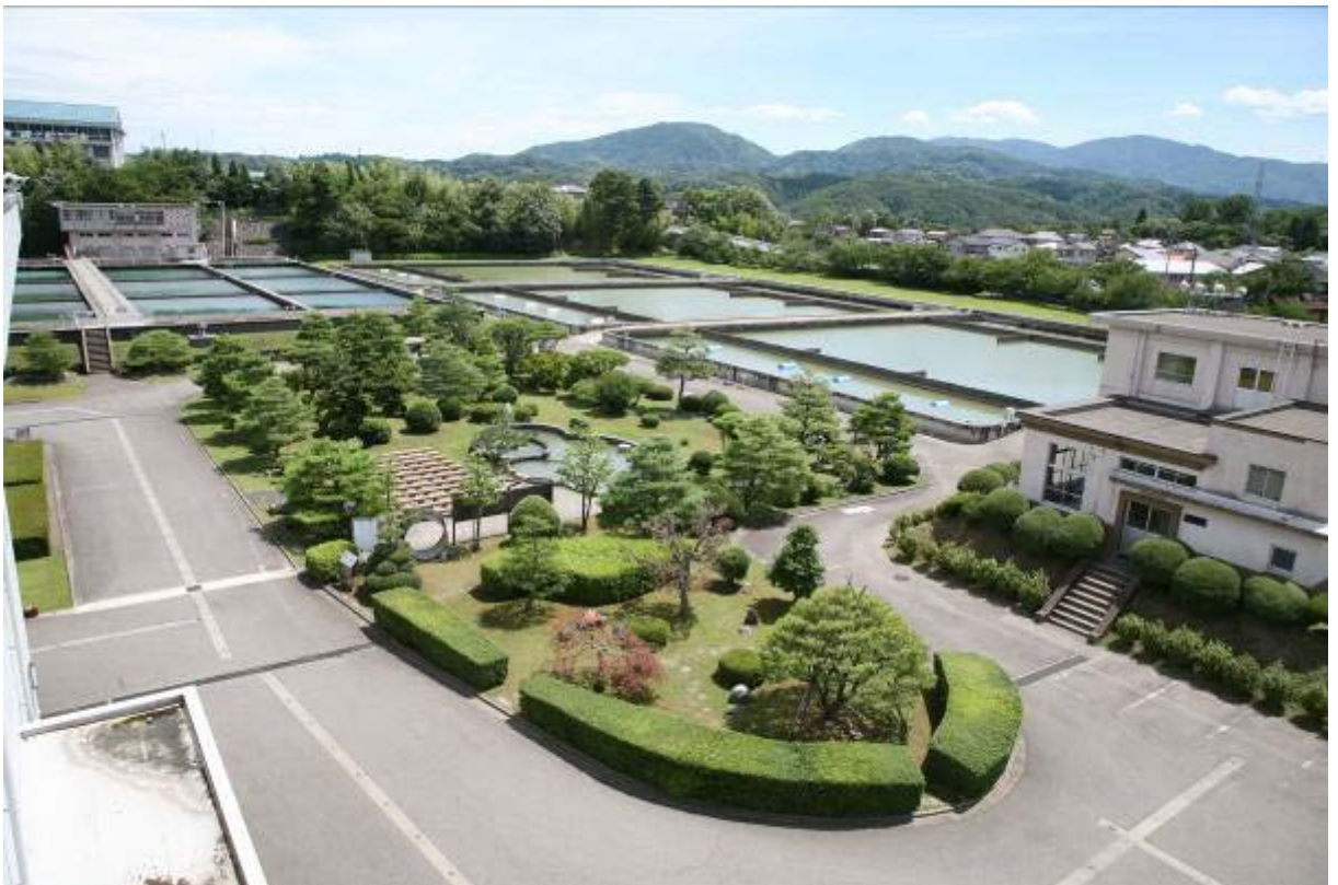
末浄水場園地 前庭全景
