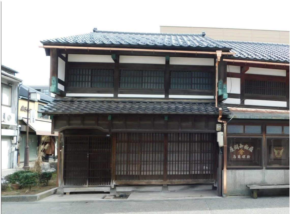
旧新保商店主屋 外観
