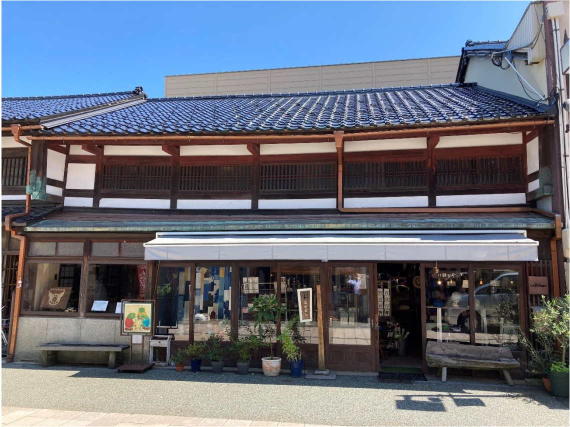
旧新保商店店舗 外観
