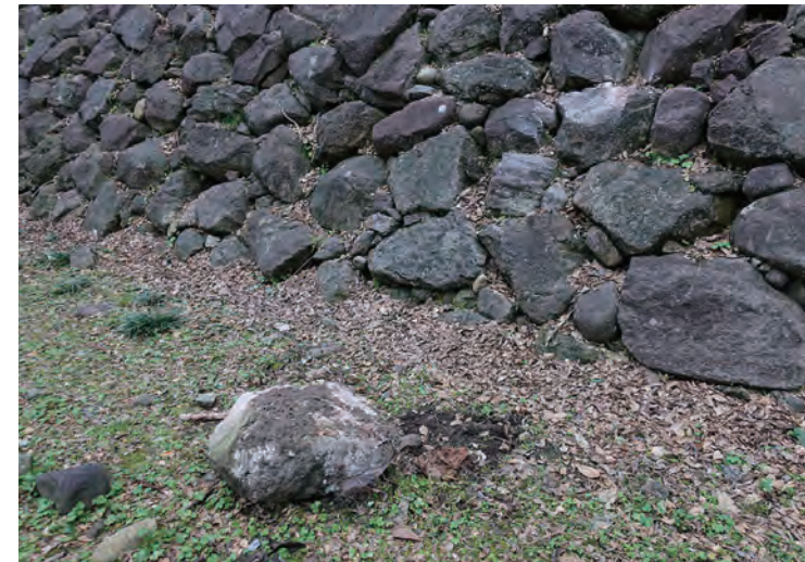
⑳ 東ノ丸東石垣 変形（落石 +9mm）
