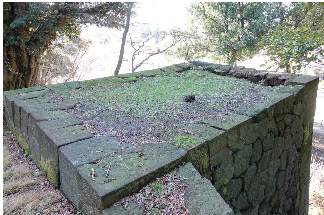
⑥ 玉泉院丸北数寄屋門台石垣 変形 (前倒れ増大 +49mm)
