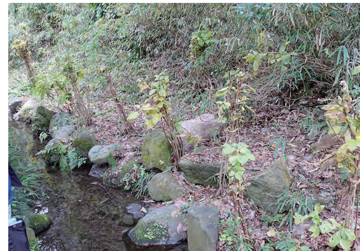
㉒ 新丸東石垣 変形（落石）
