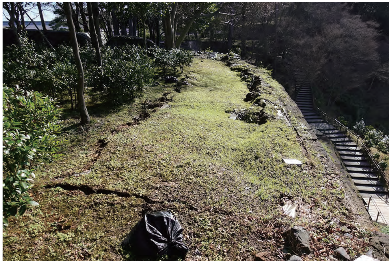
⑦ 玉泉院丸北東御居間先下石垣 変形 (前倒れ増大 +223mm)
