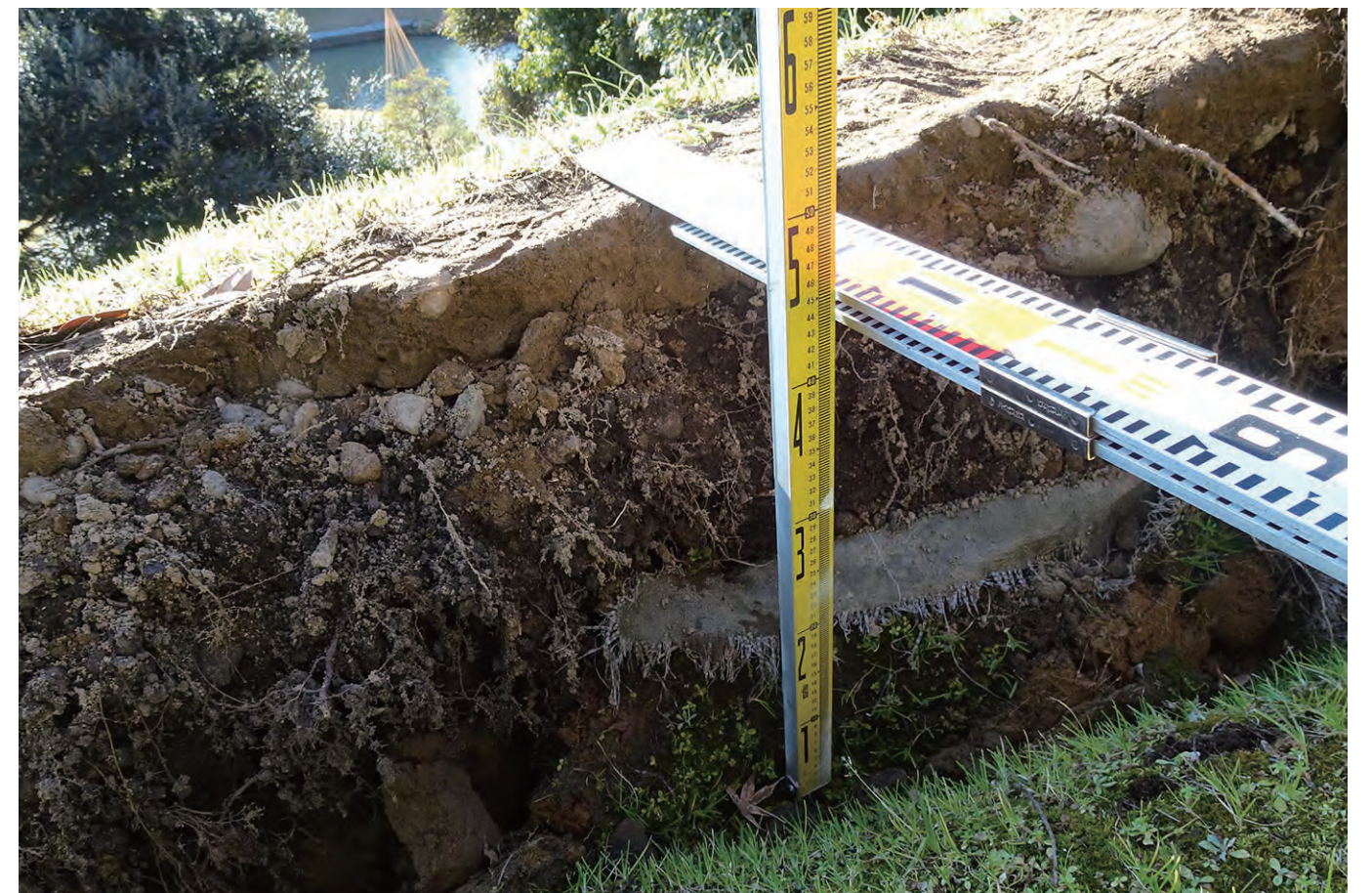
⑦ 玉泉院丸北東御居間先下石垣 変形 (前倒れ増大 +223mm)
