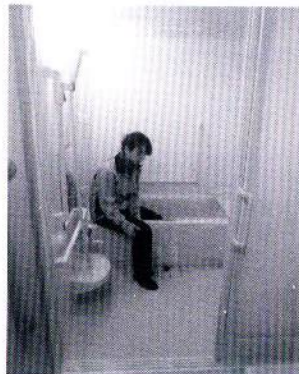
水用車いすでも利用できるバリアフリー対応タイプのユニットバスが備えられている。
