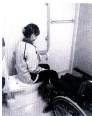
車いすでも利用できる十分な空間があり、手すりや洋式便器が備えられている。
