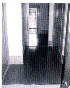
屋外から玄関、ホール、廊下、室内への動線は段差がなく、引き戸で開口も確保されている。
