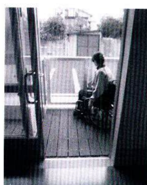
リビングから洗濯場、ベランダへも車いすで移動ができ、避難路の経路も確保されている。
