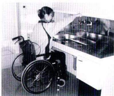
キッチンのシンクとコンロは車いすですぐ作業ができるように空間が開いている。
