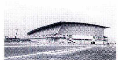
完成間近のスポーツセンター
