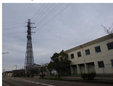
⑤送電線、クラブハウス
