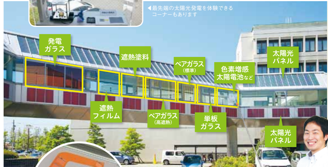
※色素増感太陽電池 (写真・左) さまざまな色で作成でき、形状の自由度も高い太陽電池として期待されています。実用化されれば、壁や窓に設置したり、インテリアに組み込んだりすることができ、従来型に比べて安価に製造できる点も魅力です。
