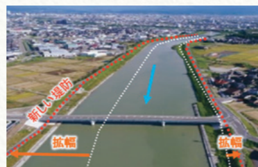
川幅を広げる河川改修(犀川(金沢市))
