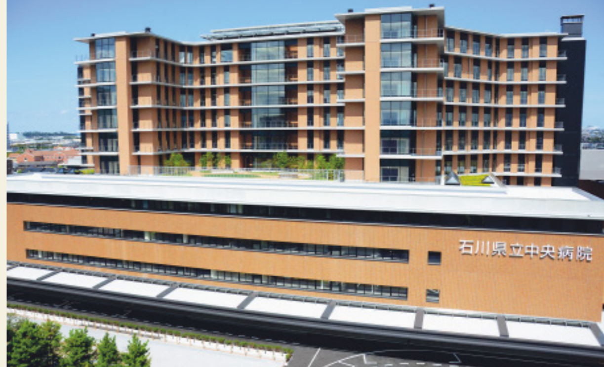
温かみのある外観に生まれ変わる新県立中央病院
