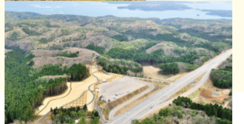
震災復旧工事に利用した土砂採取場跡地を活用し、メモリアル広場を整備しました
