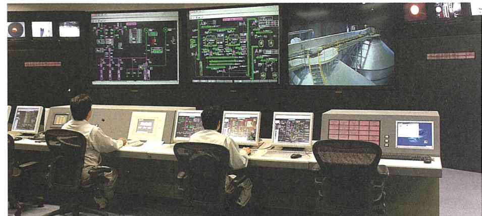
中央制御室では、焼却炉内の温度や状態などのデータを常時監視します。
