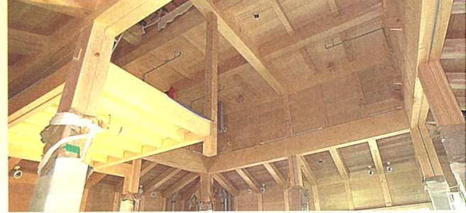
菱櫓の内部。天井の木の交差も、一角が100度、もう一角が80度の菱形になっています。
