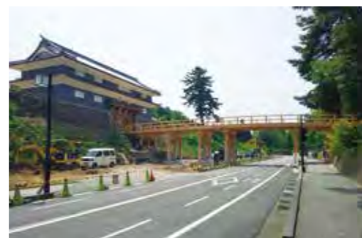
橋の高さや脚の位置など車が通行しやすいように設計
