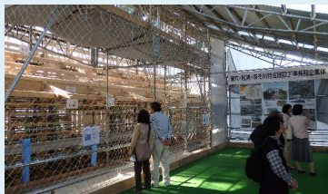
工事見学台の設置・公開 (鼠多門)
