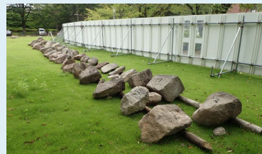
石垣復旧工事
