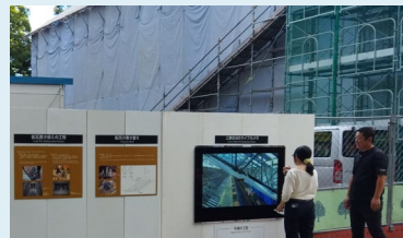
工事状況のライブカメラ配信 (三十間長屋修理)
