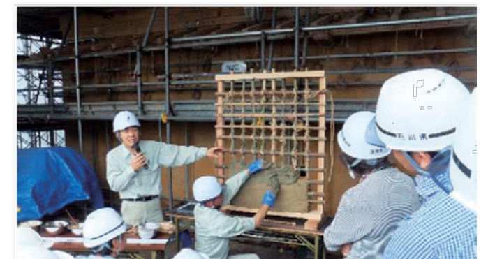
工事見学会の開催事例(鼠多門)
