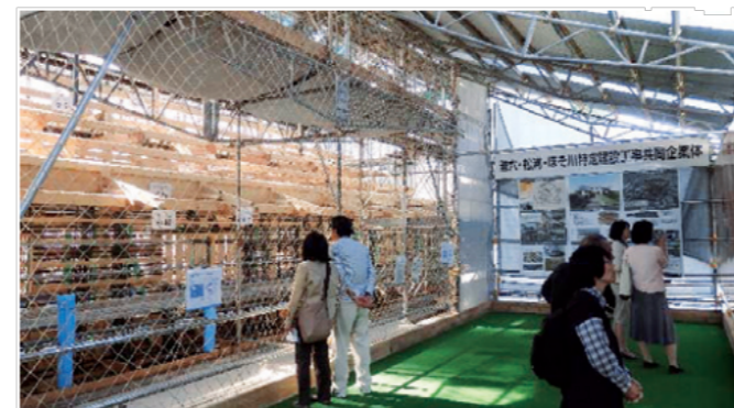
工事見学会の設置事例(鼠多門)
