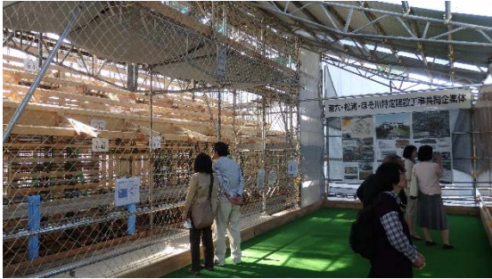
工事見学台の設置（鼠多門）
