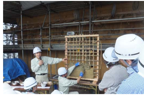
工事見学会の開催（鼠多門）
