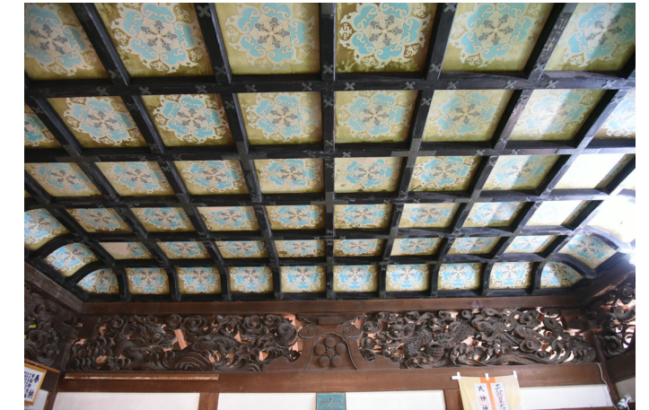
内部欄間及び天井見上
