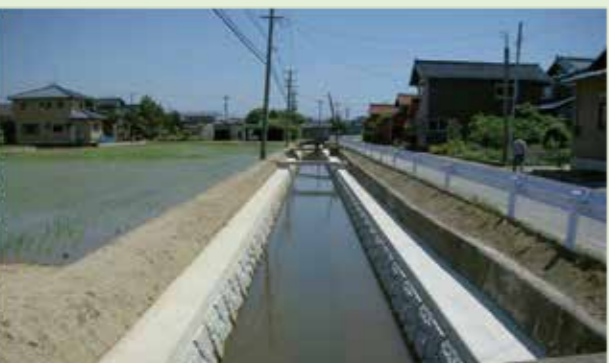
5 基幹水利施設予防保全対策事業 (小松市梯町)
