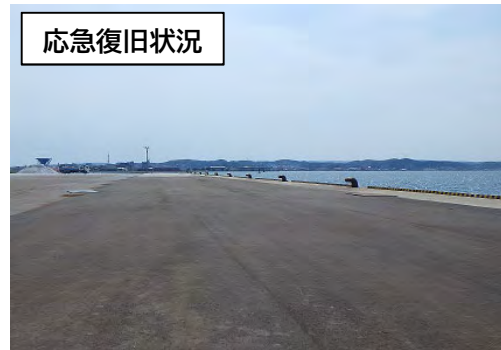
アスファルトによるエプロン応急復旧(3号岸壁)
