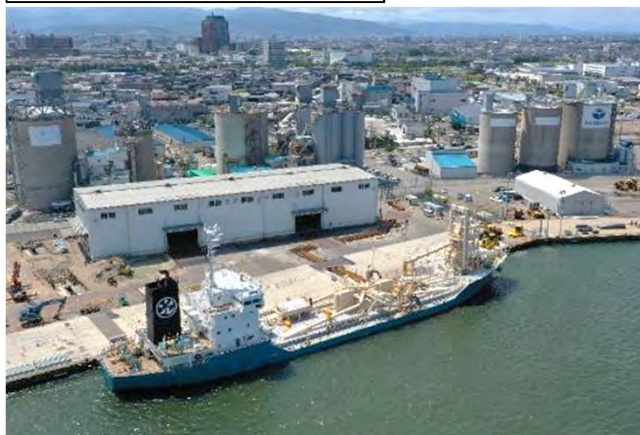
石川県のセメント需要の太宗を担う岸壁利用の再開
