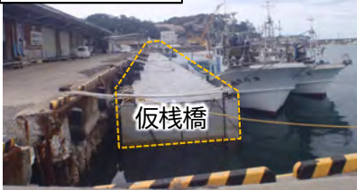
①仮栈橋設置状況(4月23日)
