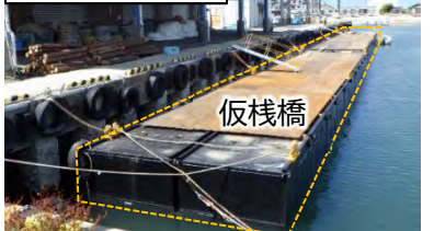
②仮栈橋設置状況(6月26日)
