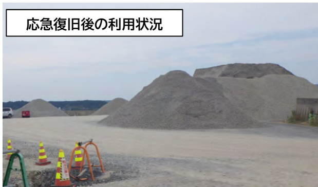
復旧資材（碎石）の集積状況
