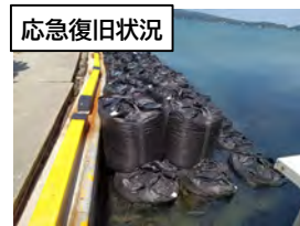
応急復旧工事完了
