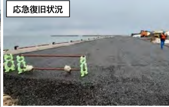
岸壁(-4.5m)応急復旧状況（1/9完了）
