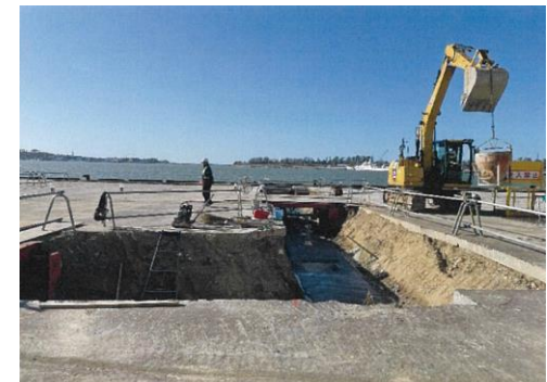
圧送用配管復旧工事
